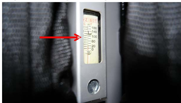
Fig. 2 Korrekt fyldt skueglas
